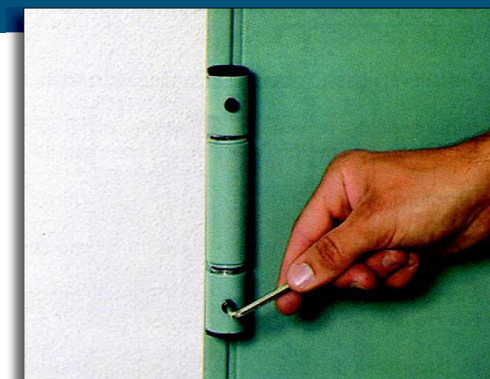
Cerniera portante dotata di viti per la registrazione verticale a sfere reggispinta
